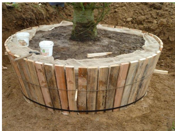
Préparation d'un bac bois
